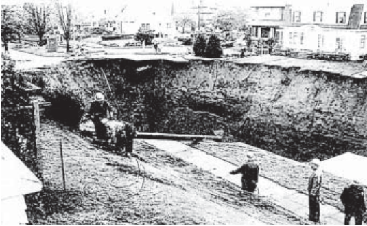
Рис. 1. Провалля, що утворилося внаслідок каналізаційної катастрофи у Сіетлі в 1957 році
