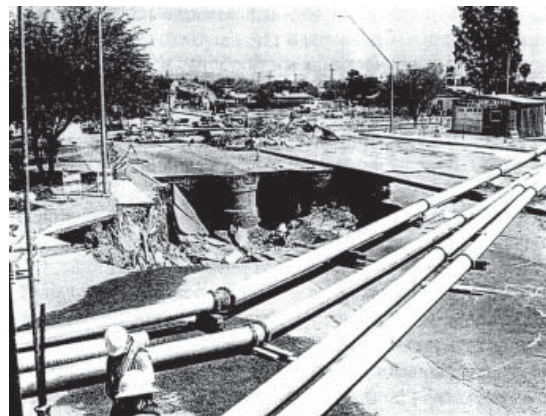
Рис. 3. Фрагмент провалля з пошкодженими підземними комунікаціями у Таксоні
