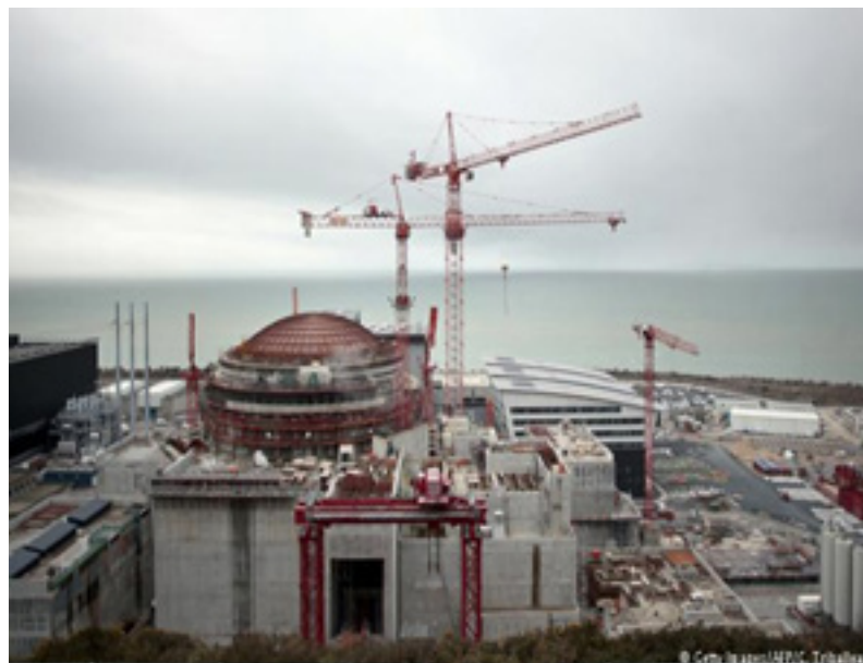
Будівництво реактора EPR
