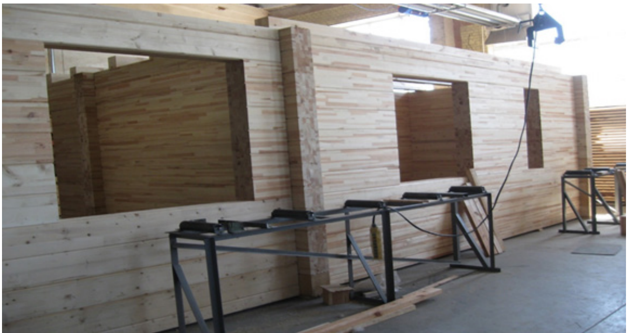
За кілька тижнів цей будинок вже буде готовий до експлуатації
